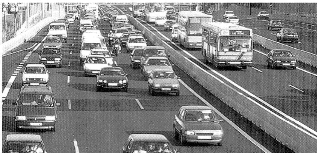
**Рис. 1.16.** Пример устройства полос движения NOV в Мадриде [169]: *а* – для автобусов; *б* – для автобусов и легковых автомобилей
